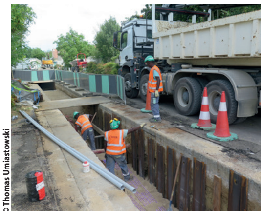
Déjà 6,8 km de travaux en cours sur les 17,8 km à terme du réseau de chaleur de Marne et Gondoire Énergie.
